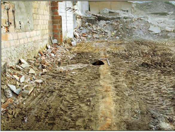
Fig. 1 - Identificação e limpeza da cloaca
