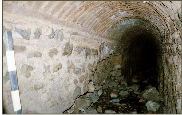
Fig. 5 - Interior da cloaca
