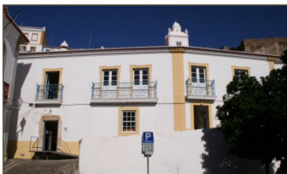
Fig. 1 – Casa do Lanternim (Mértola)
