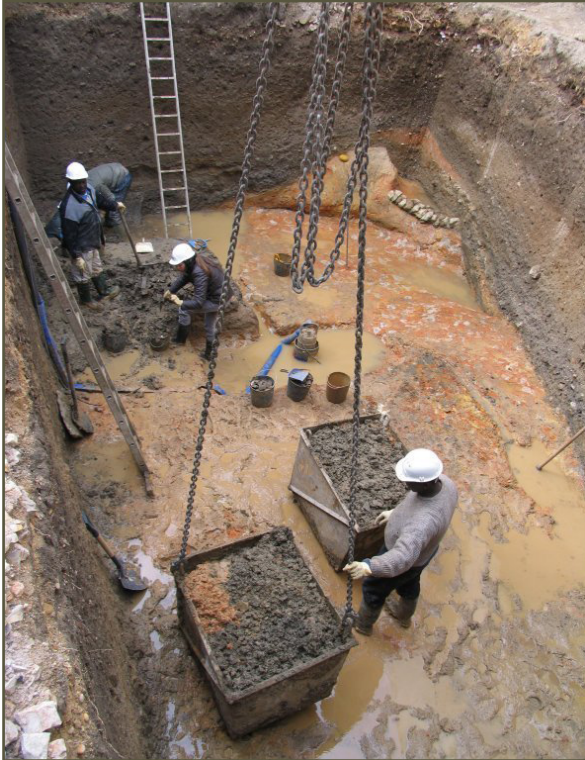
Figura 2 - Vista geral da escavação.
