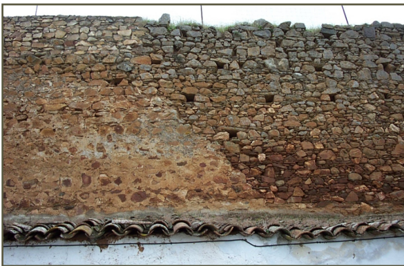
Fig. 8 - Detalle de la reparación del lienzo situado entre las torres 6 y 7 del paño norte.
