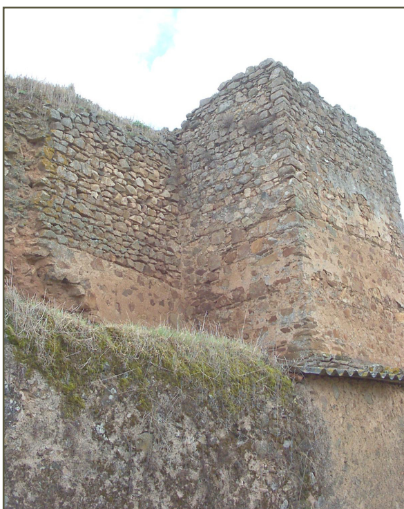
Fig. 6 - Detalle de la discriminación de fábricas en la parte superior de la torre noroeste y paño norte del recinto.
