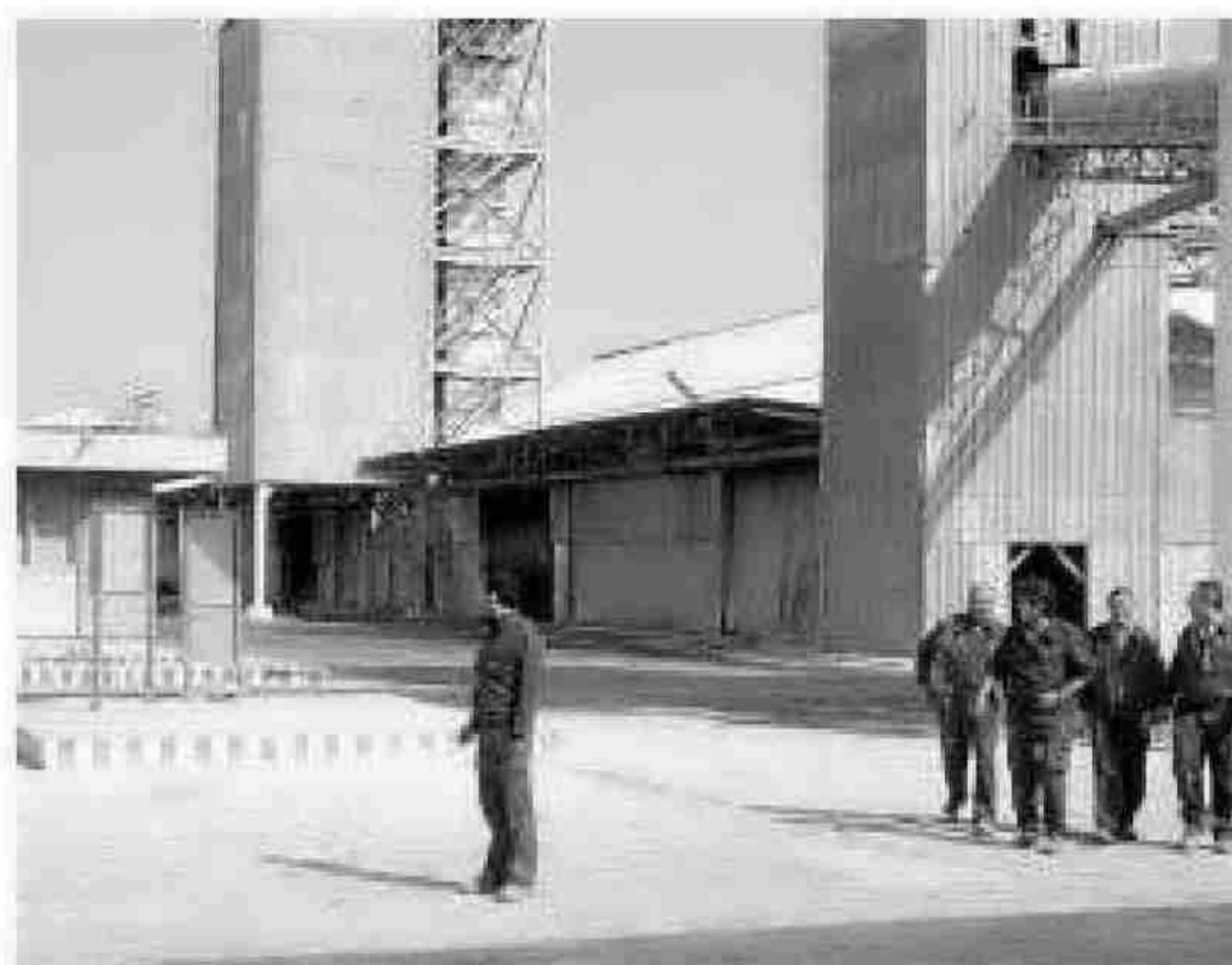
Un grupo de trabajadores en las instalaciones de Fertiberia.
