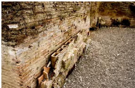
Fig. 23 Sistema de calefacción vertical
