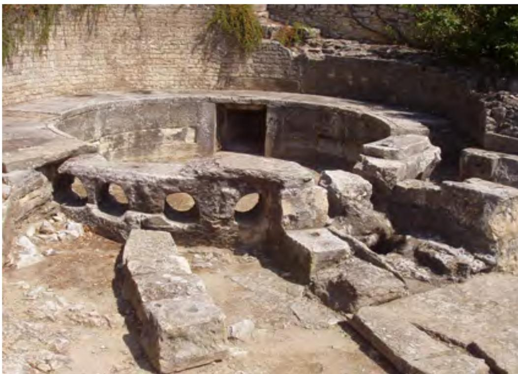
**Fig. 10 Castellum Aquae de Nîmes con diez tuberías de distribución**
