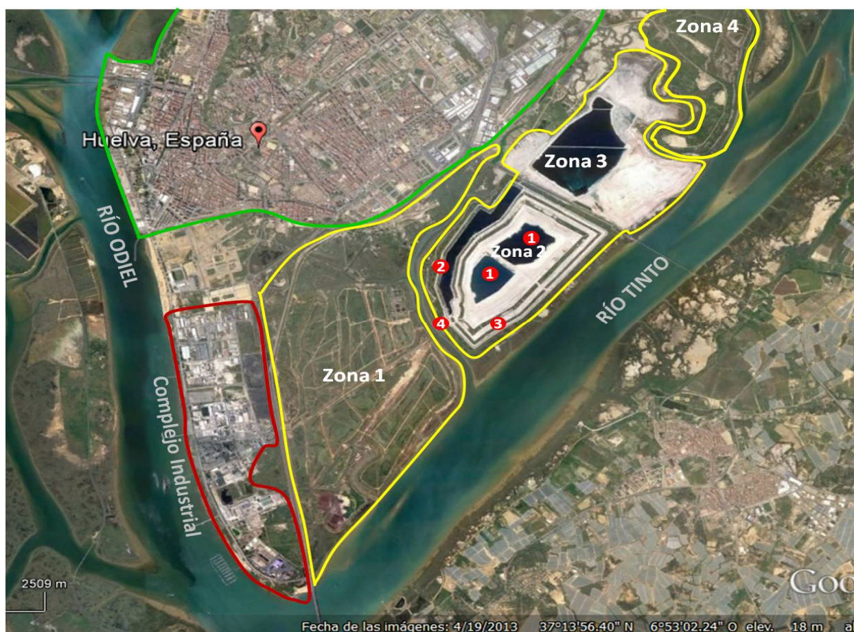
Figura 1. Fotografía aérea de la zona de las marismas del río Tinto utilizada desde 1968 para el apilamiento de fosfoyesos. (1) balsas de decantación, zona de vertido de FY; (2) embalse regulador, (3) canal perimetral, (4) estación de bombeo.
