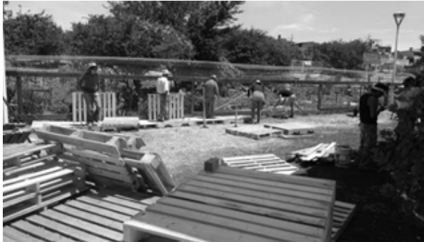
Figura 7. Proceso de construcción de PAZ.
