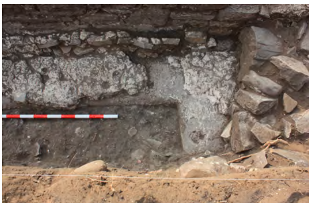
Figura 18.- Vista del ángulo sureste de la H-2, con las placas de revestimiento parietal y la reforma que cubre el hormigón hidráulico original.
