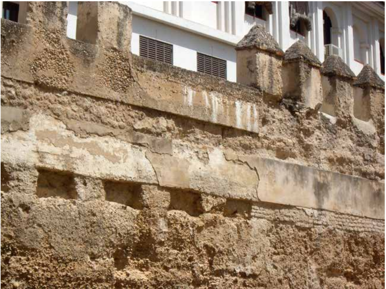
Lámina 3. Superposición de las dos fases de la muralla del Lienzo del Agua y el conducto de los Caños intercalado, que rompe los merlones más antiguos (fotografía de Daniel Jiménez).
