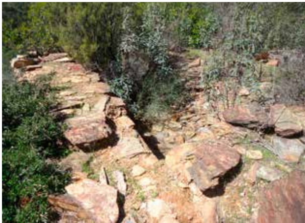
Figura 5. Muros de enlace de la torre y el recinto de la fortificación de Barranco Abadejo.
