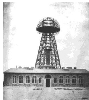
Fig. 2. La planta Wardenclyffe de Tesla en Long Island en 1904.
